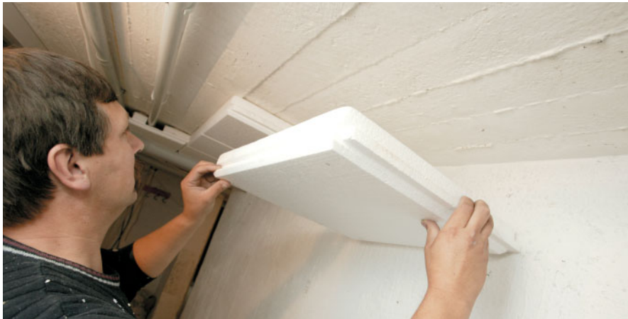
Auch das Dämmen der Kellerdecken spart Heizkosten.
