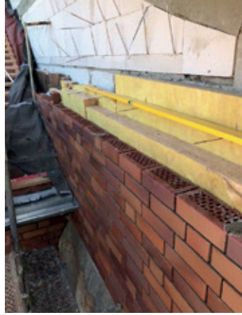
➤ Recyclebare Materialien im Einsatz: Mauerwerksdetail mit Verblendziegeln, Kalksandsteinen und mineralischer Dämmung
