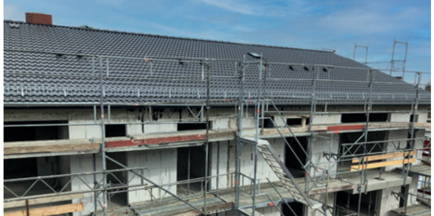
➤ Neubau in Bad Segeberg
